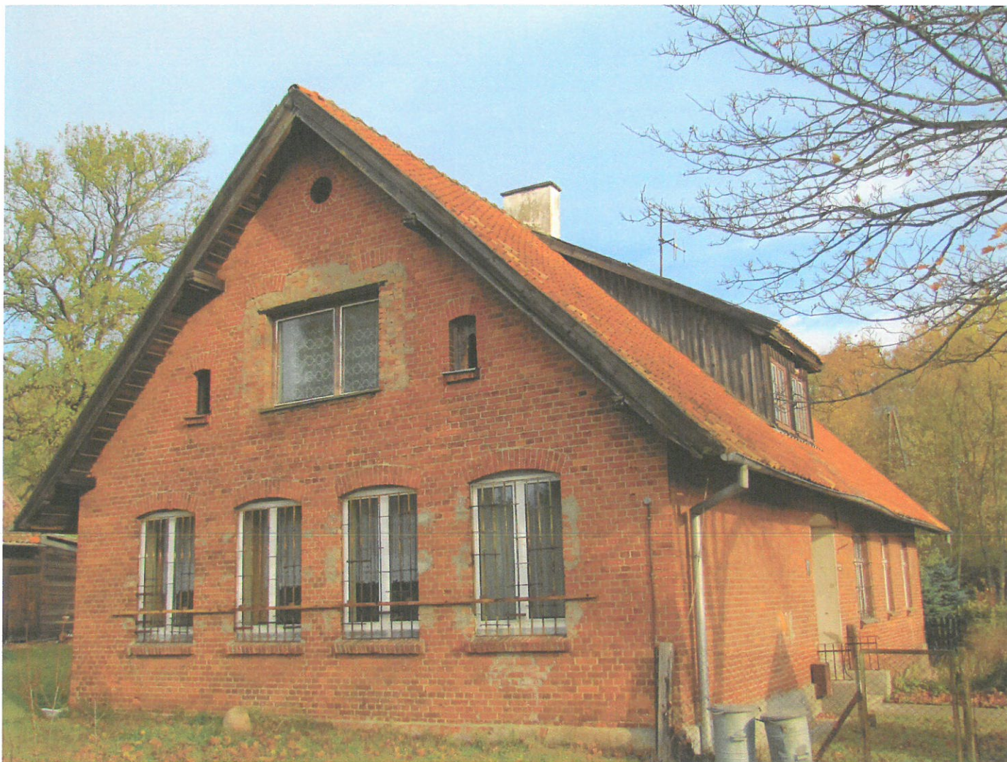
Widok ściany frontowej i szczytowej (z W na E)
