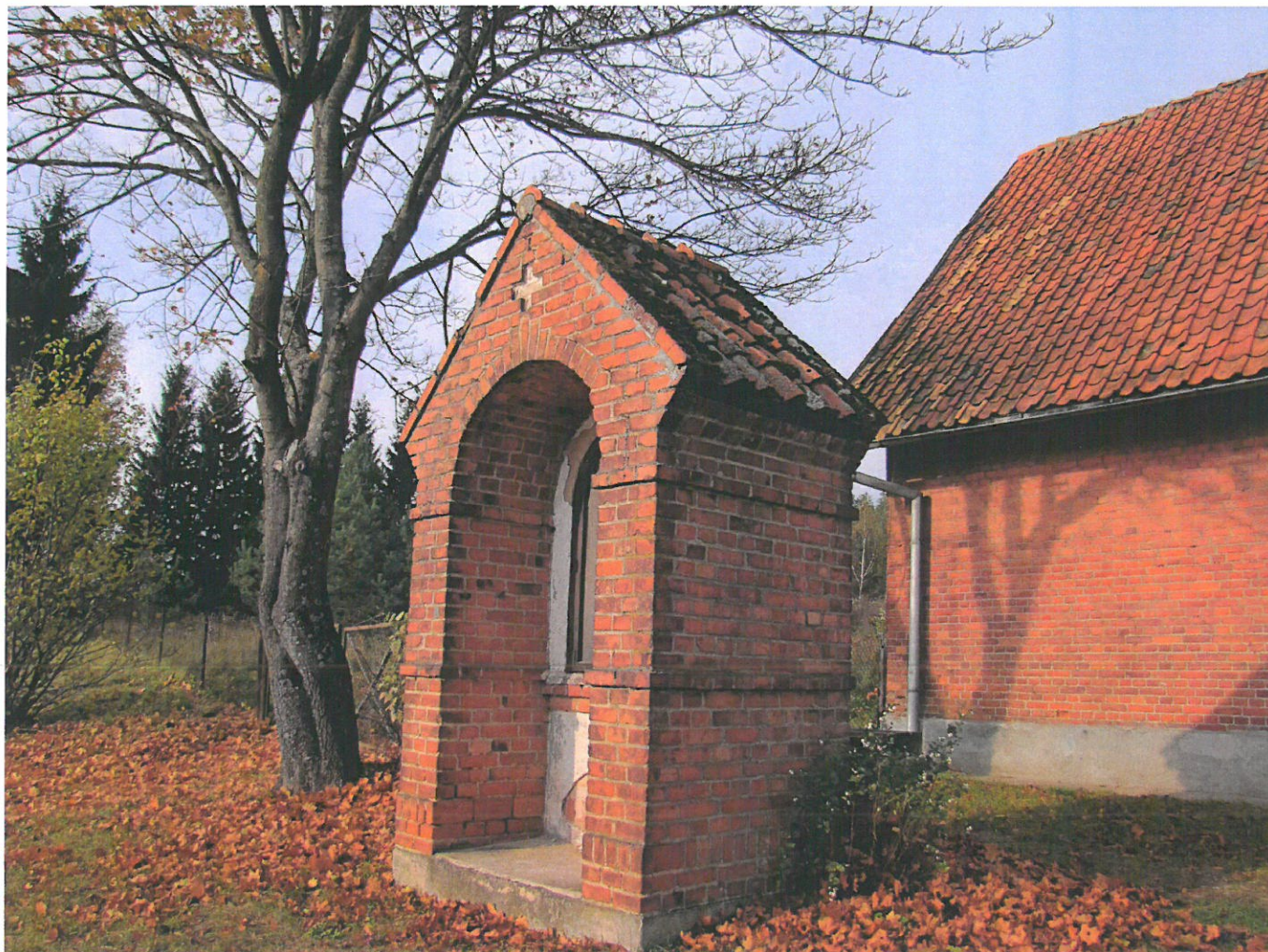
Widok ściany przedniej i bocznej (z W na E)
