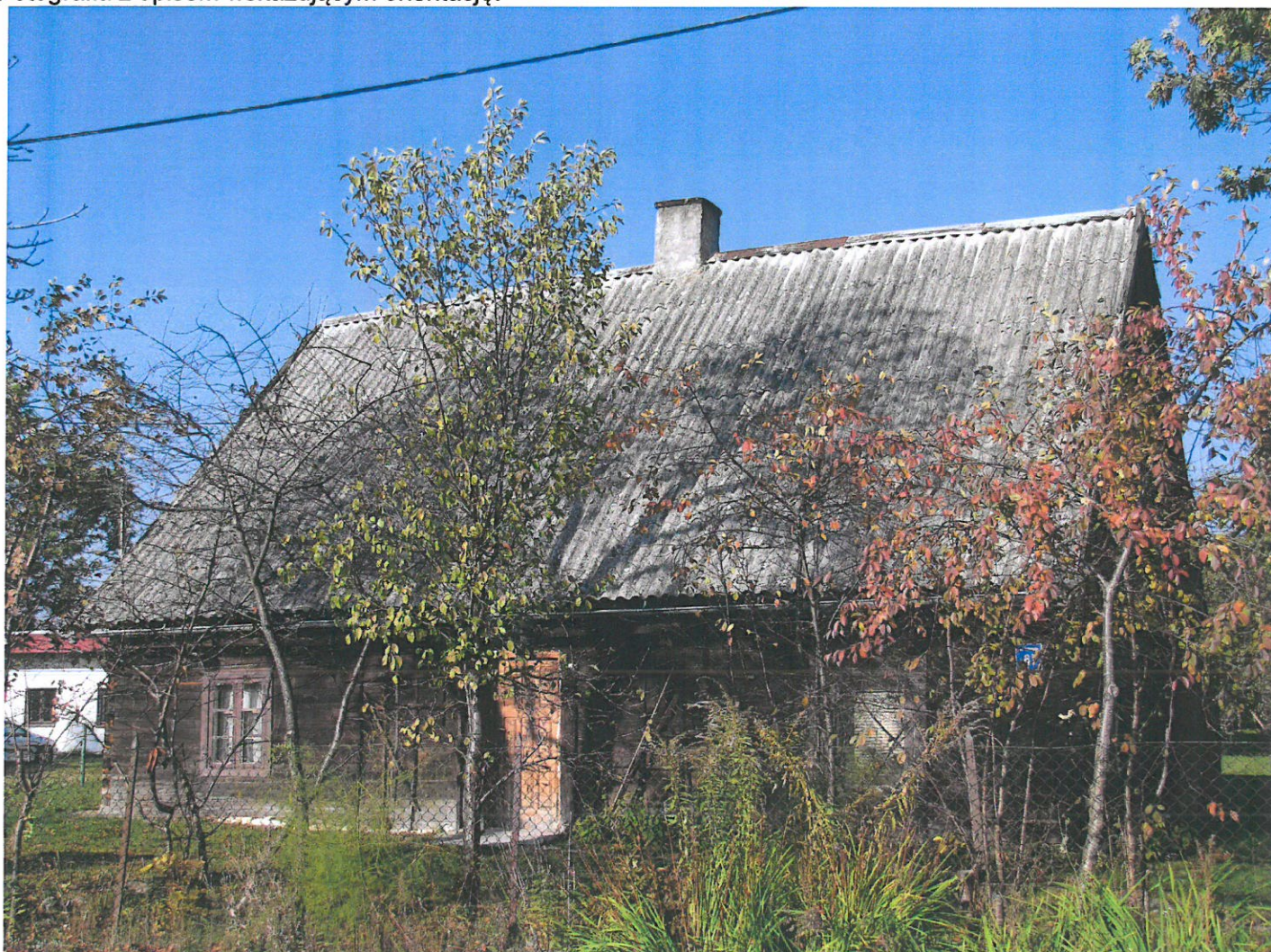
Widok ściany frontowej i szczytowej (z NE na SW)
