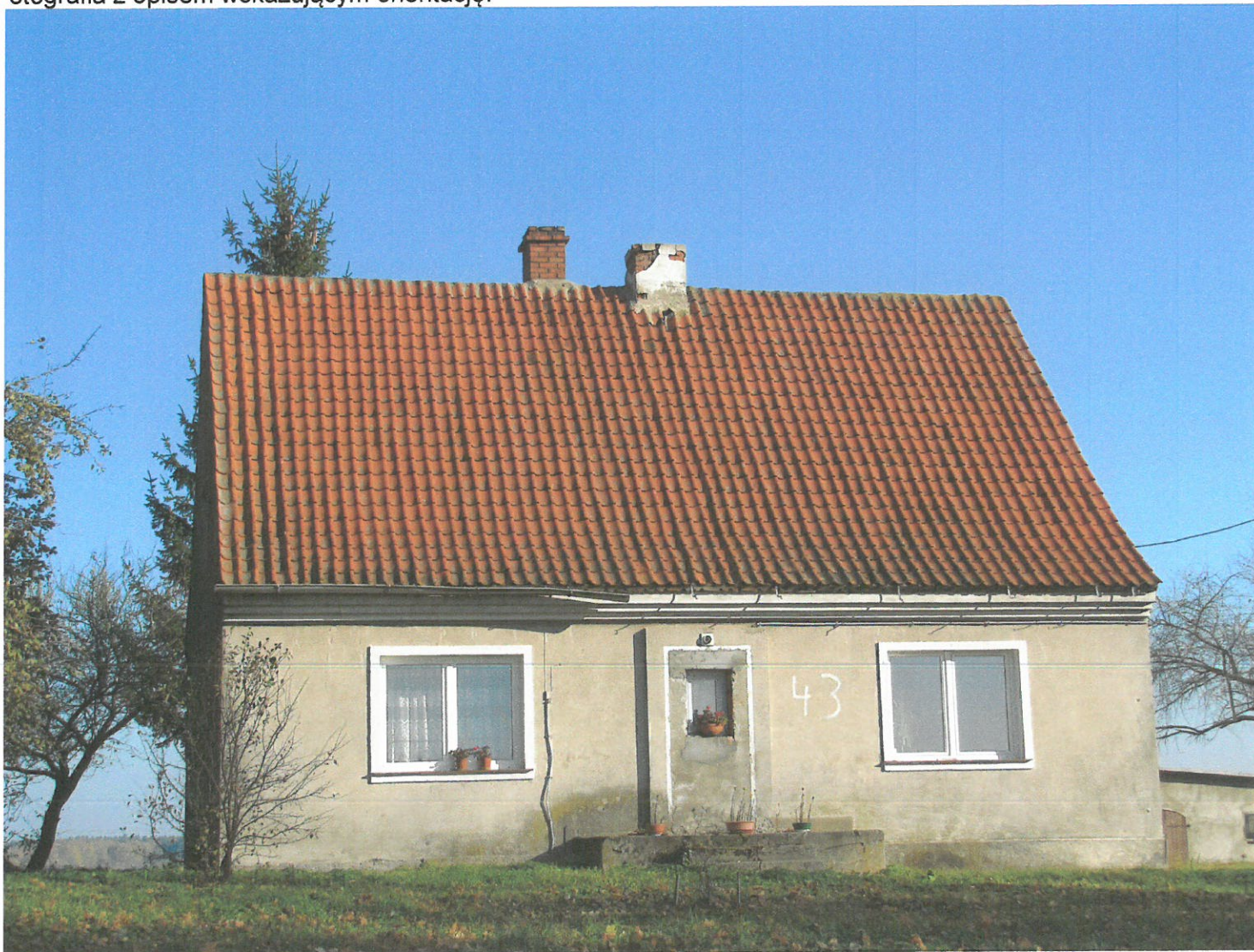
Widok ściany wzdłużnej (z W na E)
