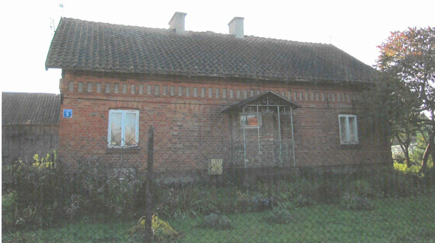
Widok ściany frontowej (z NE na SW)
