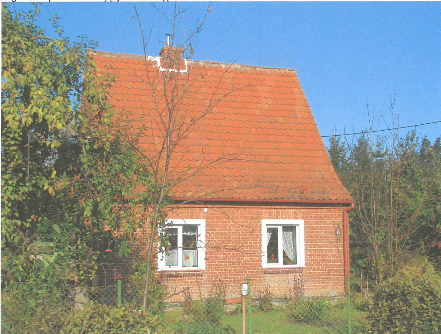
Widok ściany frontowej (z NE na SW)
