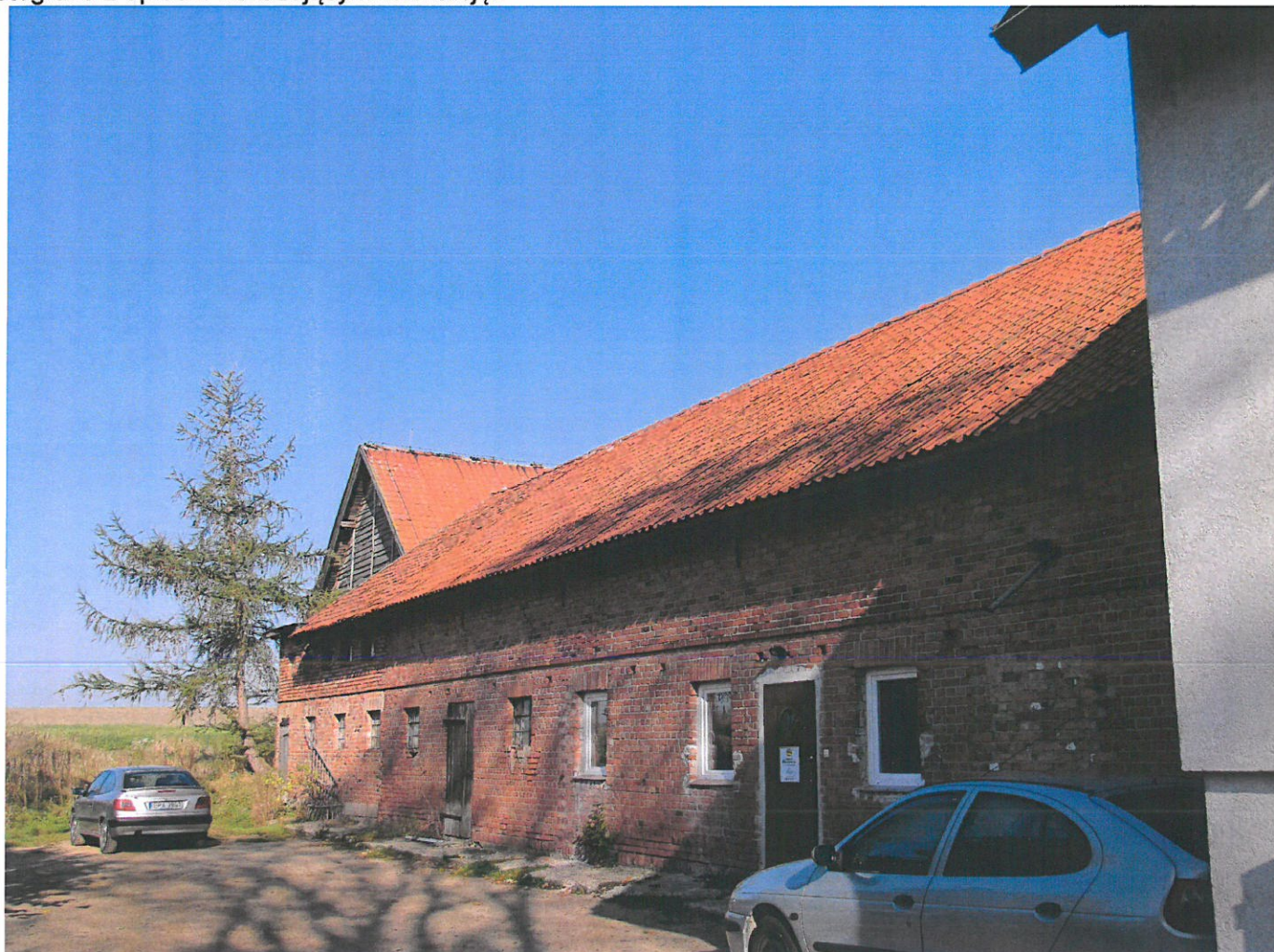
Widok ściany wzdłużnej (z W na E)
